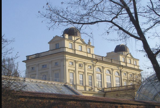
Gmach OAUW przy Al. Ujazdowskich 4 w Warszawie. Fot.: OAUW
